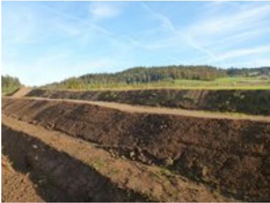
Der Bodenabtrag für die Baupiste erfolgte fachgerecht nach Bodenschicht mit entsprechenden Zwischenlagern.
