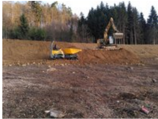
Überhöhtes Unterbodendepots infolge enger Platzverhältnisse. Da Anlegen des Depots wurde von der Unternehmung gut gemeistert - merci Paddy!
