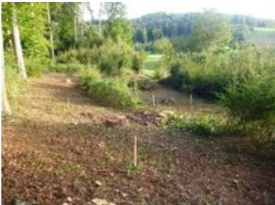
Die Lage des 110jährigen Zuflusses Emmental war nicht mehr genau bekannt. Vorgängig wurden daher Schneisen ausgeholzt, um die Sondage zur genauen Bestimmung des Verlaufs der Wasserleitung zu ermöglichen.
