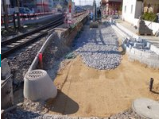
Etappenziel in Sicht: Vorschotterung des Gleises Nr. 1 im Bahnhofbereich
