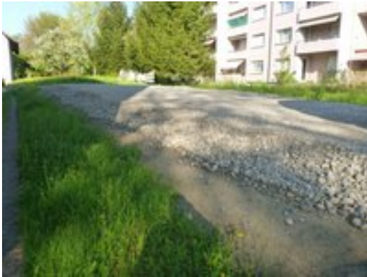
Zugang zur Baustelle mit knappen Platzverhältnissen: Baupiste Mühlebach zwischen Wohnblöcken.
