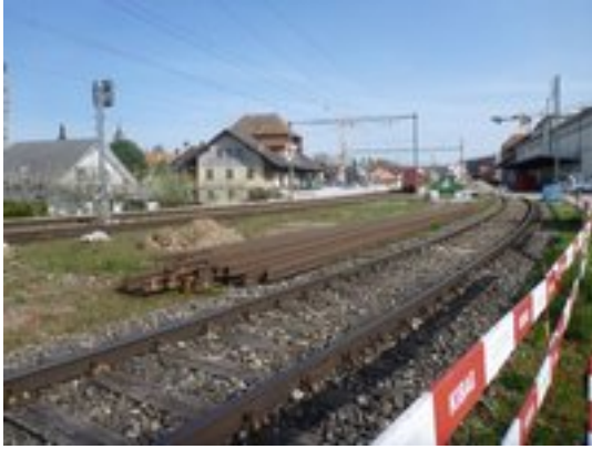
Bahnhofgelände Kirchberg-Alchenflüh von Nordende der Baustelle Richtung Süden.
