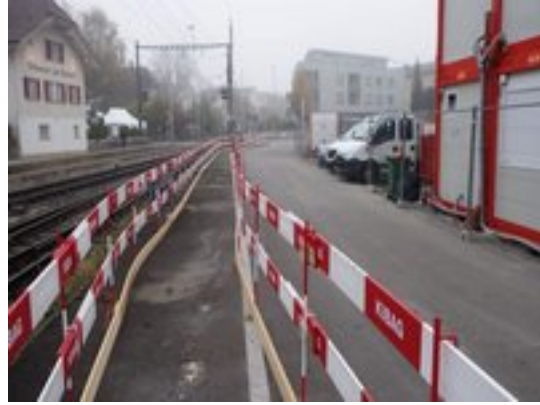
Baustelle mit viel Publikumsverkehr, die viele Absperrungen und Lenkungsmaßnahmen erfordert.
