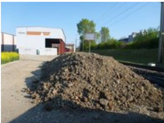
Herausfordernd: mit Bauschutt "angereicherter" Aushub aus dem Bahnhofareal, vorbildlich beschriftet durch den Unternehmer.
