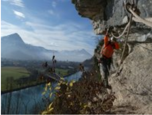
Kontrolle der Messstellen oberhalb von Ringgenberg.
