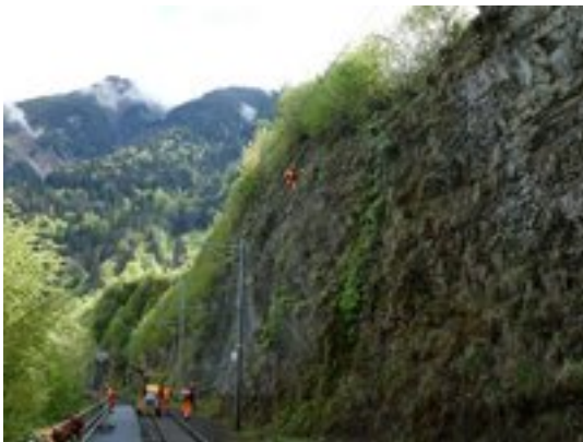
Holzereiarbeiten auf der Brünig Bergstrecke.
