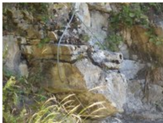
Können absturzgefährdete Blöcke nicht mittels Felsreinigung entfernt werden, müssen sie gesichert werden. Hier wurde ein Block mithilfe einer Drahtseil-Umgurtung gesichert.
