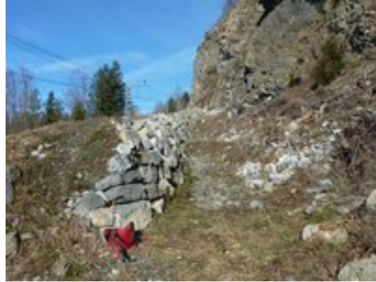
Verschiedenste Schutzbauwerke schützen die Linie der zb Zentralbahn AG. Die IMPULS AG übernimmt für die zb die Inspektion dieser Bauten.
