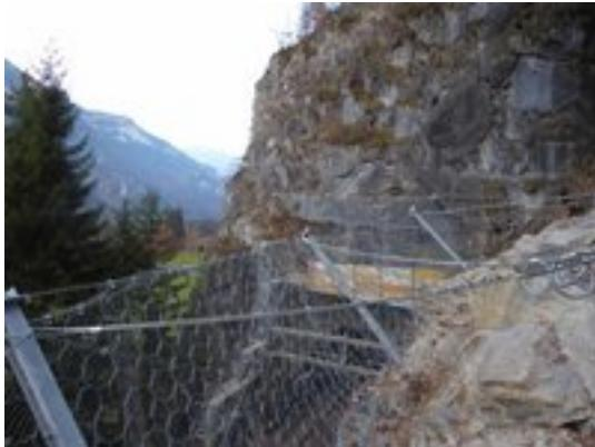
Steinschlagschutznetze im steilen Gelände: Das steile Gelände erforderte kreative Lösungen. Ein Steinschlagschutznetz über dem Tunnelportal musste mit Hilfe eines Schutzgerüstes erstellt werden. Damit die Auslenkung der Netze im Ereignisfall das Lichtraumprofil des Zugs nicht tangiert, kamen Spezialanfertigungen mit weniger Auslenkung zum Einsatz.
