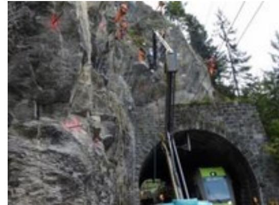
Arbeiten in der Felswand unter sehr beengten Platzverhältnissen: Die Felsabdeckungen entlang des Gleis mussten unter Betrieb erstellt werden. Dafür waren unkonventionelle Lösungen unter Einhaltung aller notwendigen Sicherheitsvorkehrungen notwendig (Einsatz von Hebebühnen, Schieben von Fahrleitungen, Arbeiten am Seil, Einsatz von Kleber anstatt Mörtel, Nachtarbeit usw.).
