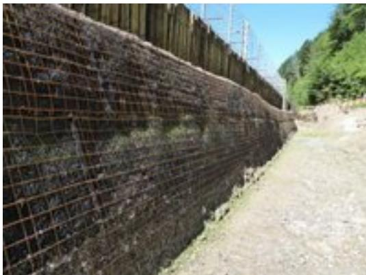
Nach der Fertigstellung: Der neu erstellte Damm, der teils bergseitig rolliert, teils erdbewehrt erstellt wurde. Die bestehende Barrage war zu erhalten. Die Erschliessung der Baustelle und der Antransport der Baumaschinen erfolgte mit dem Zug (BLS) wie auch der Abtransport des Mehraushub auf die Deponie. Alle Fotos: IMPULS AG
