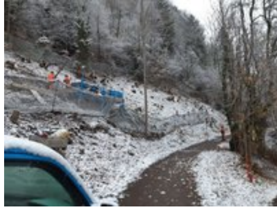
Als Vorbereitung für die Bauarbeiten wurde ein Überkopfschutz installiert, um die Arbeitssicherheit zu gewährleisten. Zum Schutz der unterhalb der Baustelle liegenden Strasse und Gebäude wurde ein temporärer Abrollschutz erstellt.
