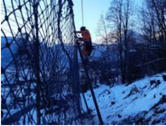
Arbeit am Oberbau des Steinschlagschutznetzes.
