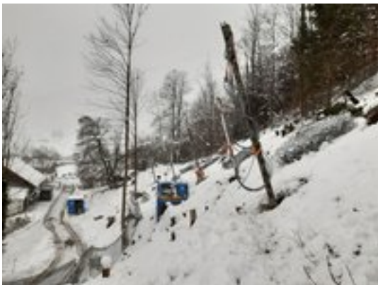
Montage des Oberbaus bei winterlichen Verhältnissen.
