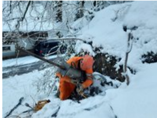
Ankerzugprobe an einem Anker, an dem ein seitliches Abspannseil des Steinschlagschutznetzes befestigt wird. Der Anker wurde durch den im Bild erkennbaren Findling hindurch im Untergrund verankert. Eine Verankerung nur im Findling hätte den berechneten Kräften bei einem Ereignis möglicherweise nicht standgehalten.
