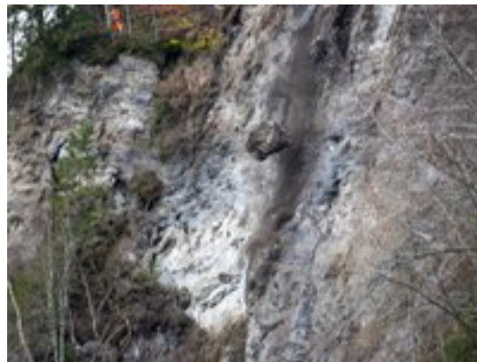
Abstürzender Block während der Felsräumung
