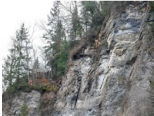
Blick von der Seite in die Abbruchstelle. Druckkissen für den kontrollierten Abtrag von instabilen Felspartien werden durch den Unternehmer platziert.
