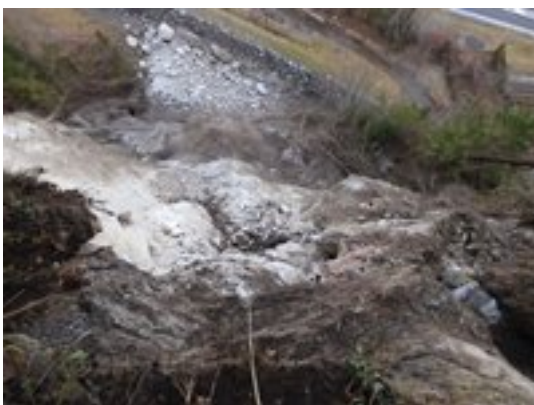
Blick von oben auf die Sturzbahn und den Auffangbereich hinter dem Steinschlagdamm
