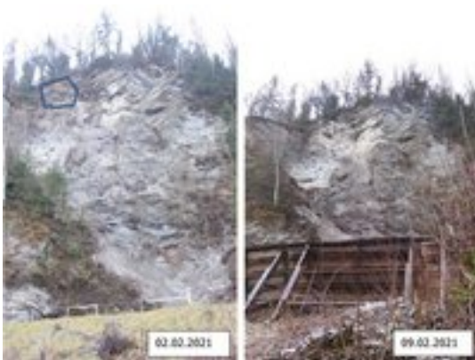
Links: Blick von unten zum Ausbruchgebiet. Blau markiert: akut absturzgefährdetes Felspaket. Rechts: Der gleiche Bereich nach der Felsräumung.
