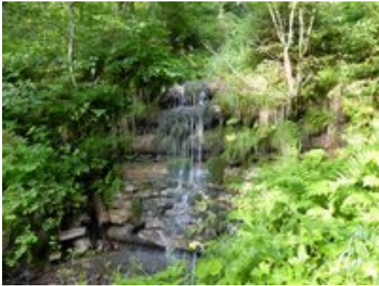
Geländeaufnahmen: Die Bandbreite der angetroffenen Schutzbauwerke war riesig, betreffend Alter, Werkart und -typ und Zustand. Von sehr alten Holzbauwerken an Seitengerinnen...
