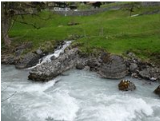
Geländeaufnahmen: Entlang der Lütchine wurden Duzende Buhnen der unterschiedlichsten Bauweisen erfasst
