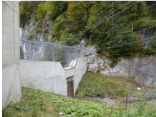
... bis zu modernen, grossen Betonrückhaltebauwerken
