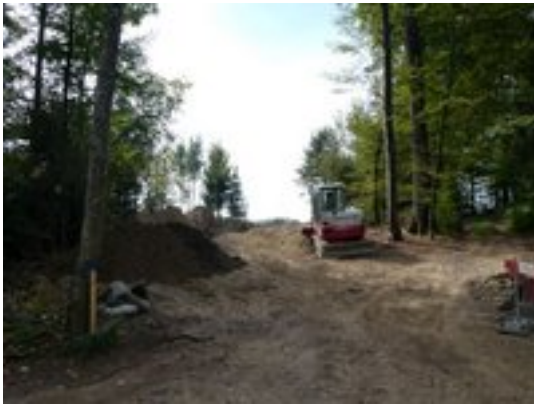
Rekultivierungsarbeiten: die zuvor entfernten Bodenschichten werden wieder aufgetragen.
