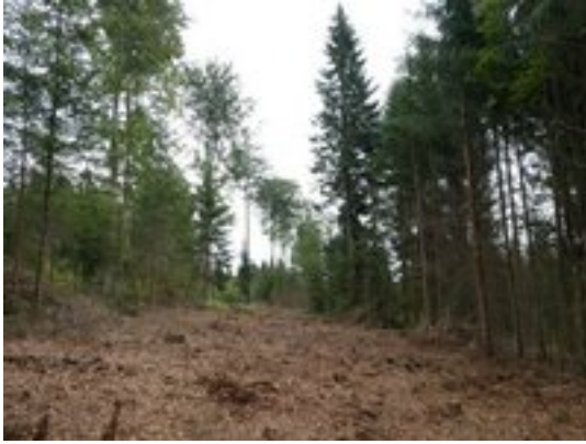
Gerodete und für die Erdarbeiten vorbereitete Waldfläche.
