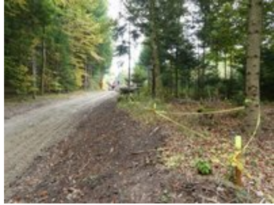
Schutz der Orchideen neben dem Bauprojekt.
