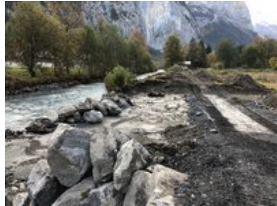
Bauphase: Aufweitung des Gewässers und Einbau der formwilden Blöcke-
