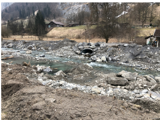
Einbau von Raubäumen und Blöcken im Gerinne. Erstellung von Kleinstrukturen im Uferbereich.
