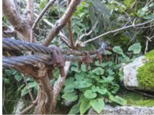
Die Werke werden auf Schäden / Mängel untersucht und die Schäden müssen bewertet werden
