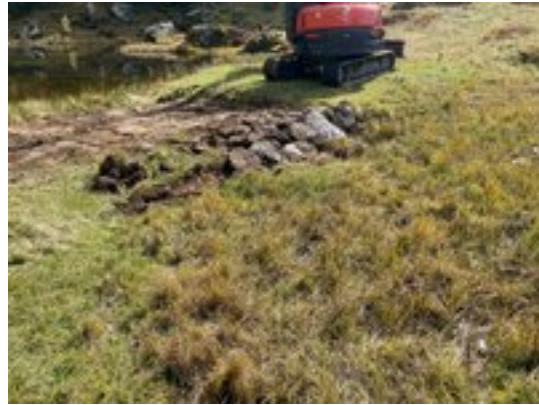
Bauphase: Verbesserung des Wasserrückhalts mithilfe eines Damms.
