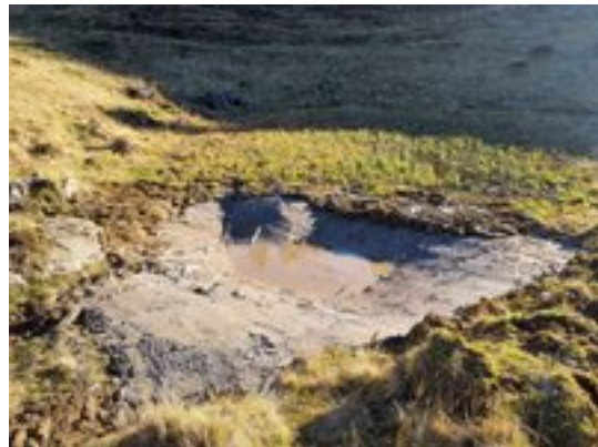
Bauphase: Eine dicke Lehmschicht hält hier künftig das Wasser zurück.
