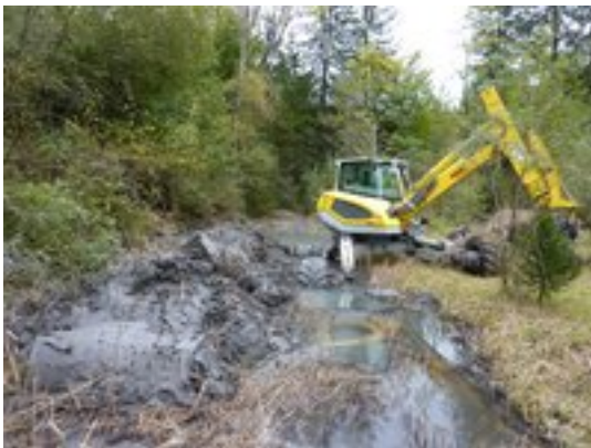
Bauphase: Die Weiher wurden sorgfältig ausgehoben.
