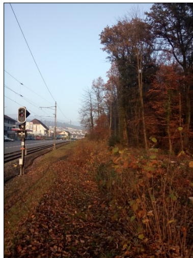
Bauleitung und Kontrolle Sicherheitsholzerei
